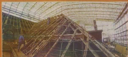
Arbeiter haben einen Teil des Daches vom Kirchenschiff bis auf die Stahlkonstruktion freigelegt. Sie bleibt erhalten. Damit nicht jeden Abend eine riesige Abdeckung über das offene Dach gebreitet werden muss, schützt eine riesige, teure Zeltkonstruktion die Baustelle.
