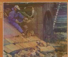
Ein Arbeiter beim Abriss des Michel-Dachs. Bis Ende des Jahres soll die Nordseite fertig sein. Ab Januar folgt die Südseite zum Hafen hin.
