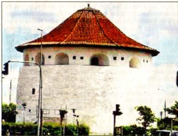
Etwa 20 Meter im Durchmesser und 18 Meter hoch: Der Pulverturm von Frederikshavn vor der Restaurierung.
