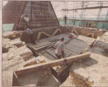
Bevor das untere Turmstück nach oben gezogen wird, befestigen Handwerker in über 50 Metern Höhe die Verankerung des Bauwerks in der sogenannten Glockenstuhlebene.
